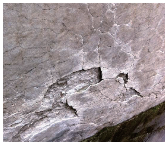
图 A.8 层片状剥落
