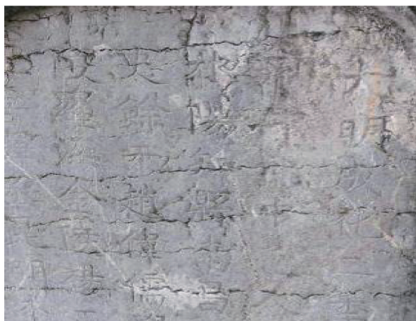
图 A.3 风化裂隙
